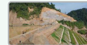
Tailing Dam, Kota Bunyi
