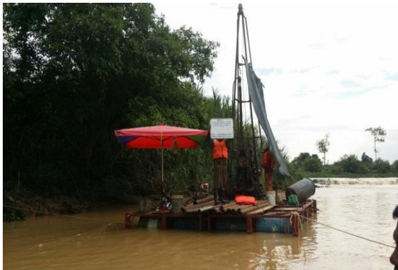
Kerja-kerja Meningkatkan Sumber Air Mentah Di Loji Rawatan Air Gemas
