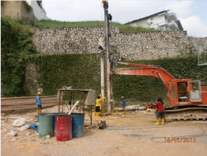
2013.05.16 : MICROPIILING INSTALLATION
